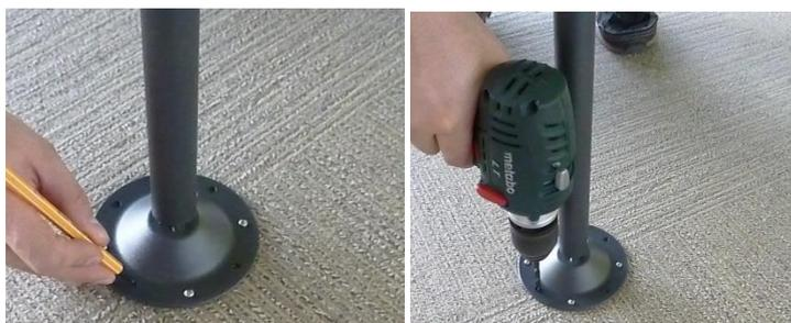
11. Marquer la position des trous de fixation des pieds, puis percer les trous pour les chevilles ou les ancrages qui maintiennent le support.
