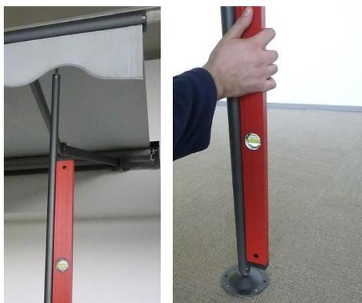
10. Placez les supports en position verticale à l'aide d'un niveau à bulle.
